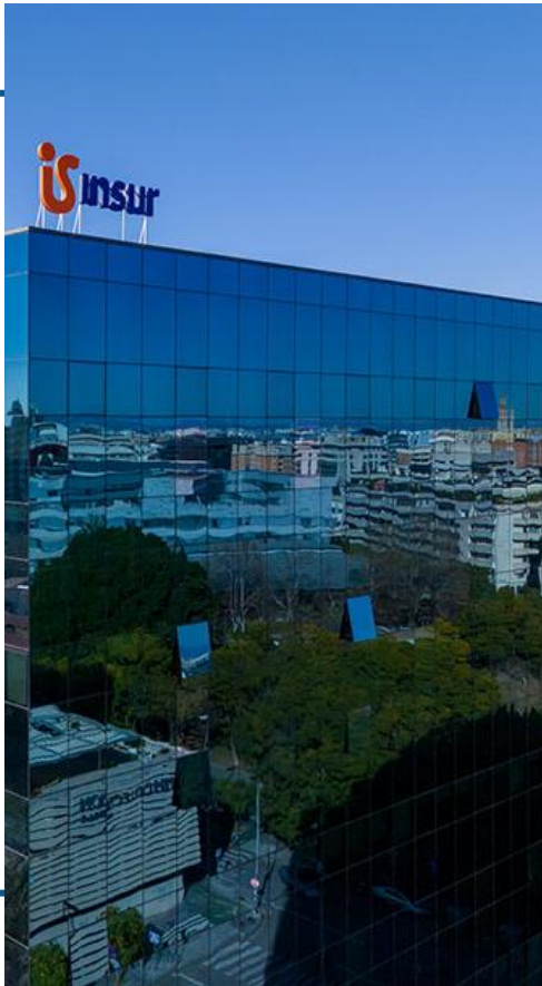
EDIFICIO INSUR – SEVILLA
